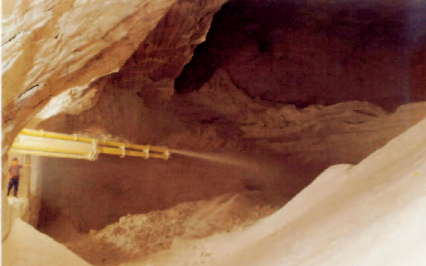
**Verfüllung: Ein Luftstrom bläst Salz in eine alte Abbaukammer der Asse**
