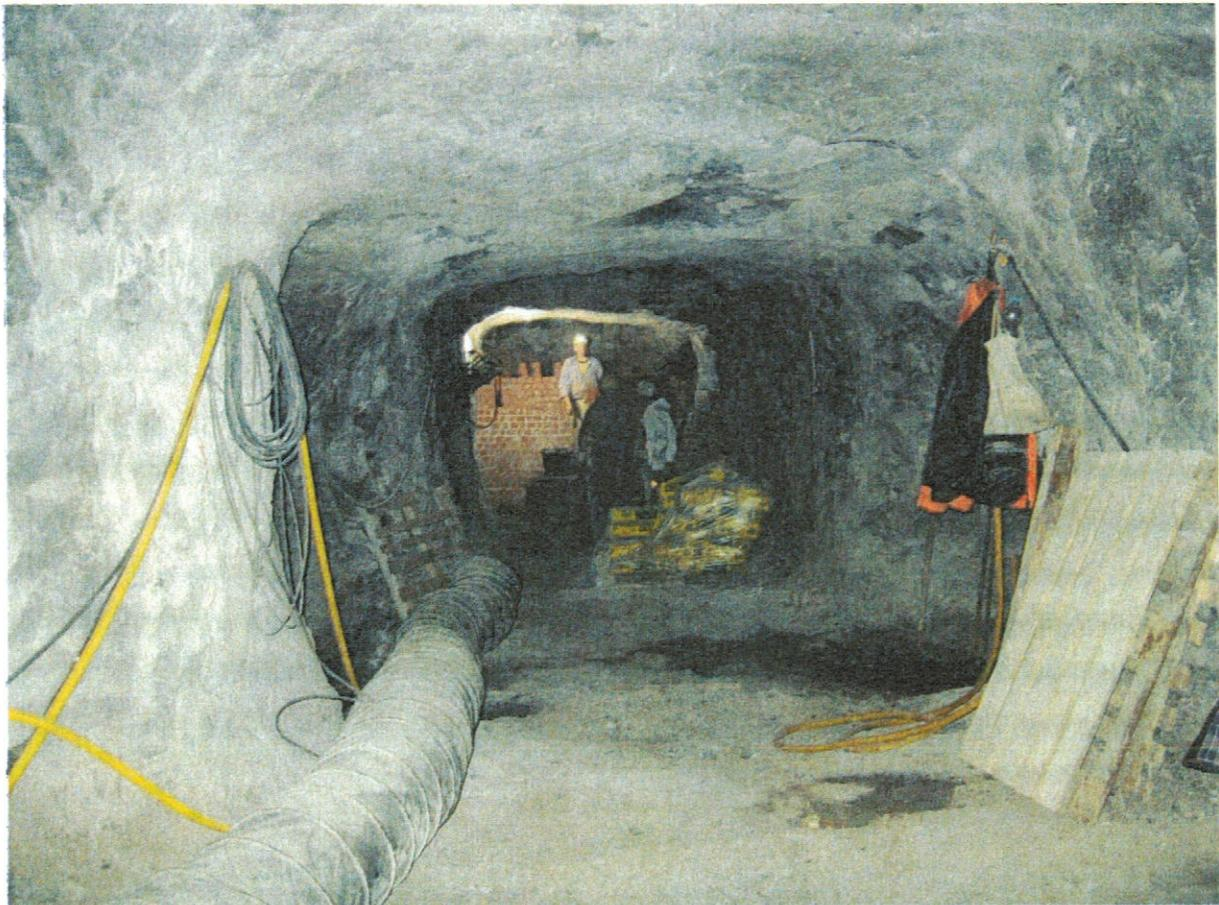
*Bild 3.4.1: Versuchsstrecke für das Abdichtungsbauwerk im Anhydrit, Bleicherode 16.02.10*
